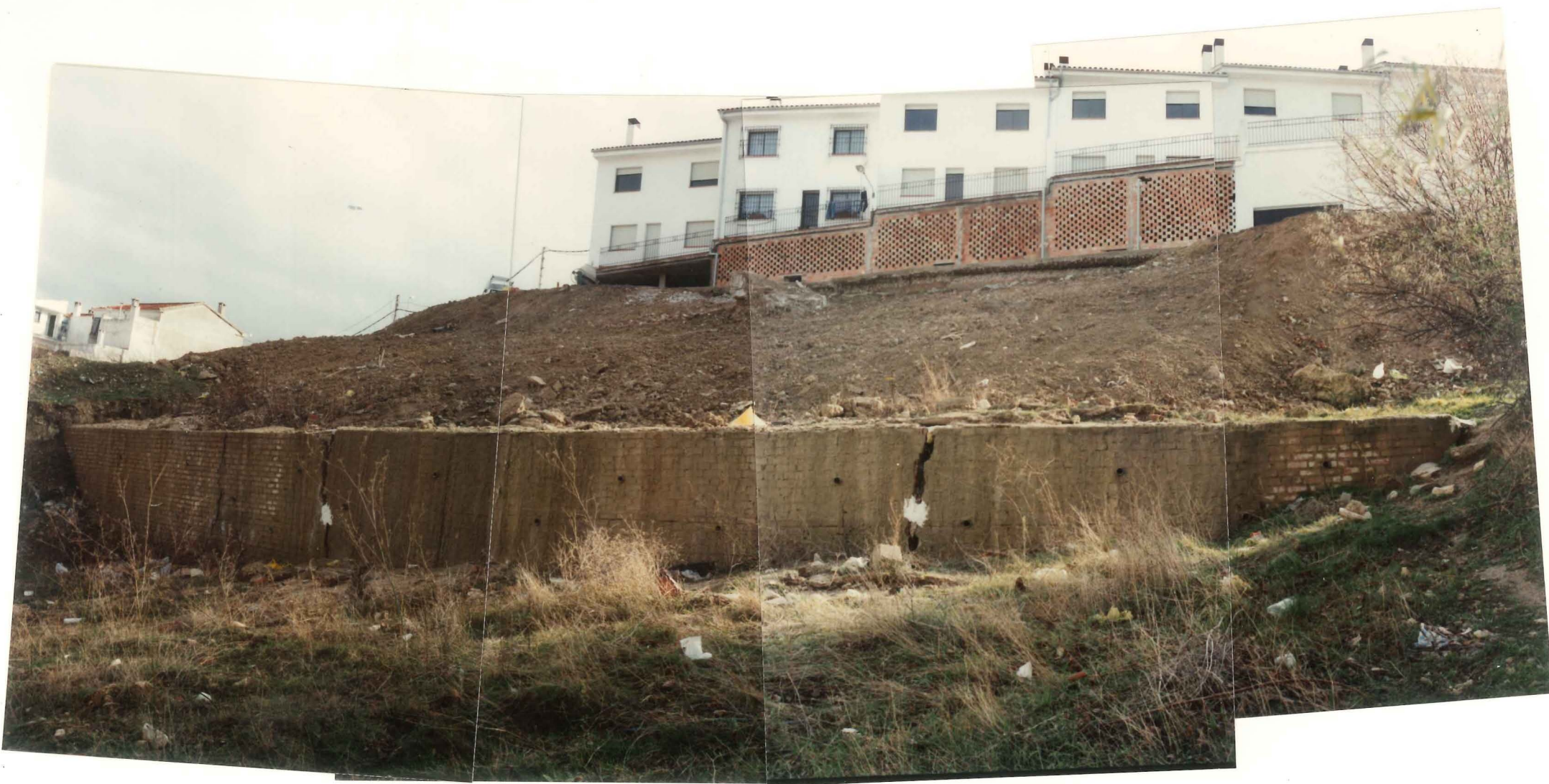
FOTOGRAFIA 2: Vista general del deslizamiento estudiado. Observese los daños sufridos por el muro, carente de armadura.
