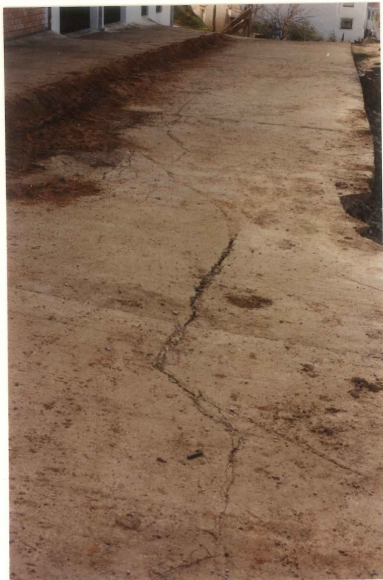
FOTOGRAFIA 5: Grieta de tracción en la coronación.
