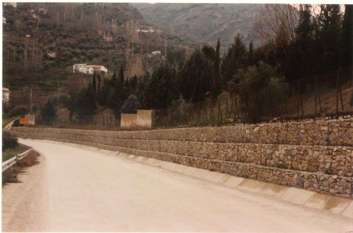
FOTOGRAFIA 8: Vista del muro flexible de gaviones que se ha instalado junto al Polideportivo. Esta actuación ha resultado muy positiva.
